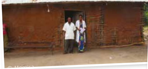
Ancien centre de santé de Dunda
